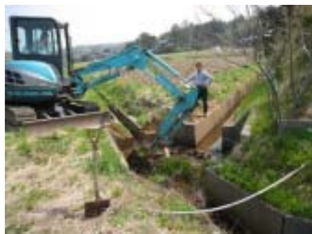
機械による用・排水路の土砂撤去
